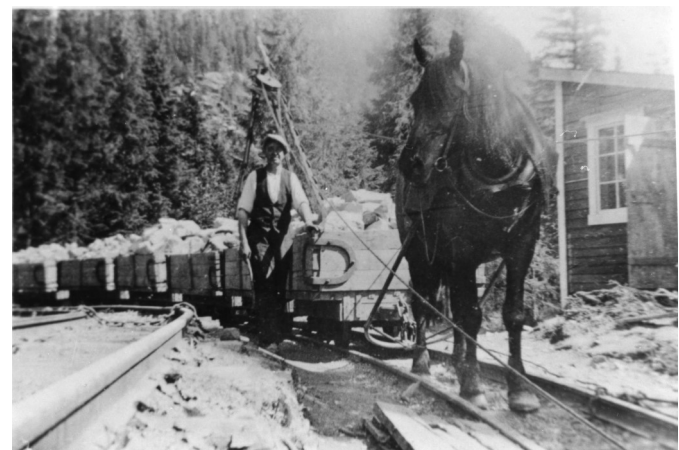
Transport av tunellmasse frå Hægebostadtunnelen 1936, Foto: Hægebostad
